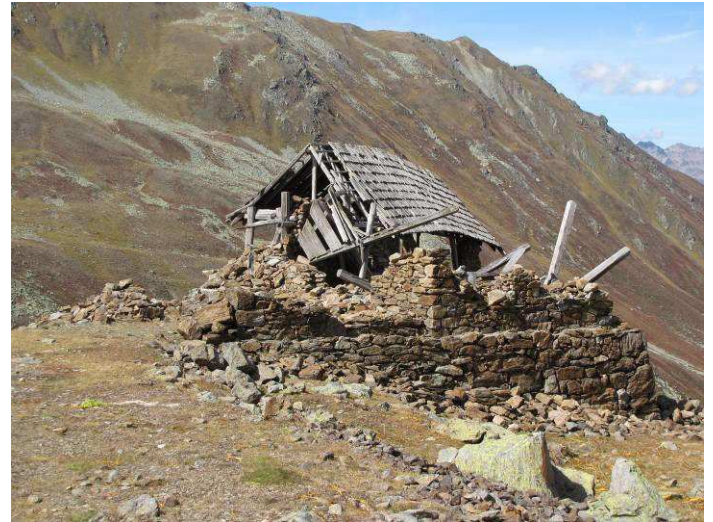
Abb. 10: Verfallene Bergstation der Materialseilbahn, Zustand von 2010 vor der Renovierung
