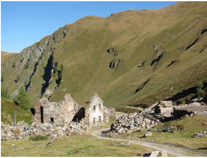
Abb. 7: Die ehemalige, heute großteils verfallene Erzaufbereitungsanlage
