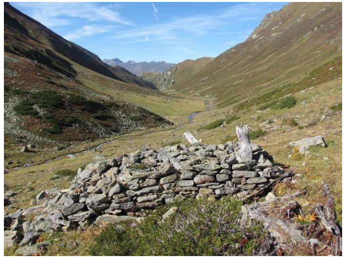
Abb. 8: Mastfuß von Mast 10 der ehemaligen Materialseilbahn, Blick nach Norden
